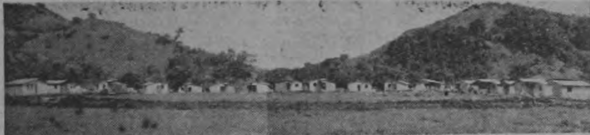
Vista panorámica del conjunto de 18 casas para familias campesinas, que entregó el INVU el Domingo 17 de Junio en Santa María de Dota. Las viviendas fueron construidas en terreno céntrico y gracias al apoyo oportuno económico del Convoy de Cooperación Nacional. — También la Municipalidad de Dota ayudó a esta obra lo mismo que el MOP.
